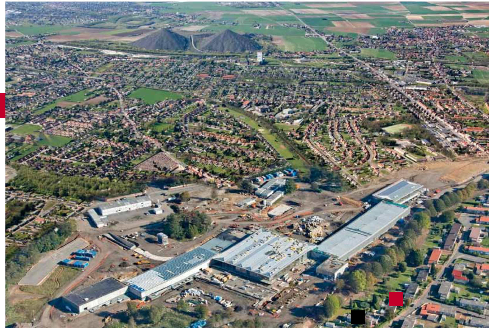
Musée du Louvre-Lens - Vue aérienne du Chantier Louvre - Lens
